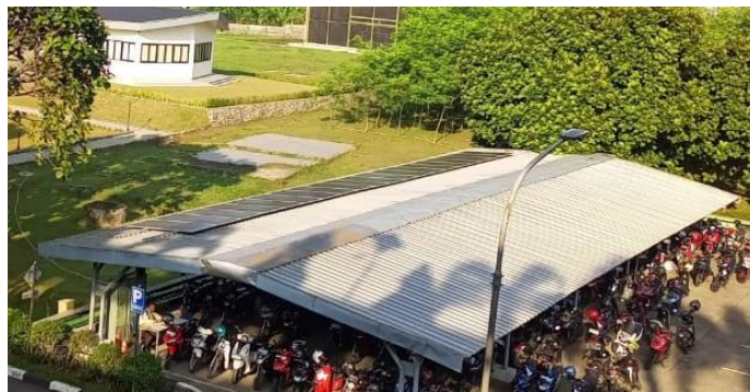
Gambar 4.1. PLTS yang telah terpasang ke arah utara kemiringan 9^\circ
