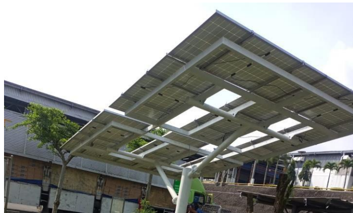
Gambar 4.3. PLTS yang telah terpasang ke arah selatan kemiringan 8^\circ
