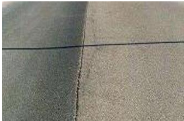
Gambar 2. 9 Retak Sambung (Joint Reflection Cracking)
